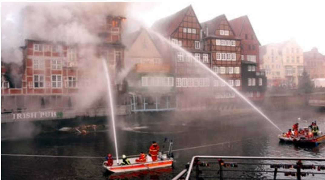
02. Dezember 2013: Großbrand am Lüneburger Stint. Das historische Gebäude brannte aus. Alle Bewohner konnten gerettet werden.
