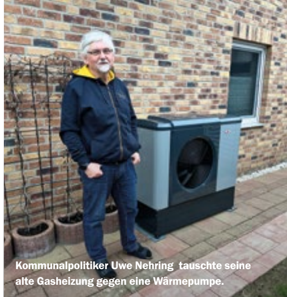
Ausseneinheit der Wolf Wärmepumpe
